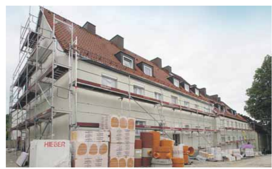
Im Vorfeld der Sanierung wurden die Mieter der Dornierstraße 4–10 1/2 gebeten, eine Liste zu erstellen, welche Renovierungsarbeiten sie sich am meisten wünschen.
