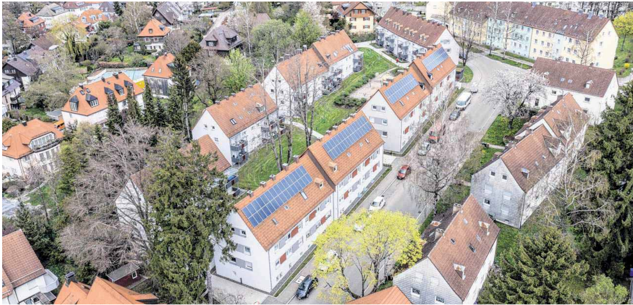
Die Häuser Ellharter Straße 24 sowie Dornierstraße 5, 7 und 9 (rechts) im Kemptener Westen will die Baugenossenschaft Kempten heuer abreißen und dann dort neu bauen. Fotos: Ralf Lienert
